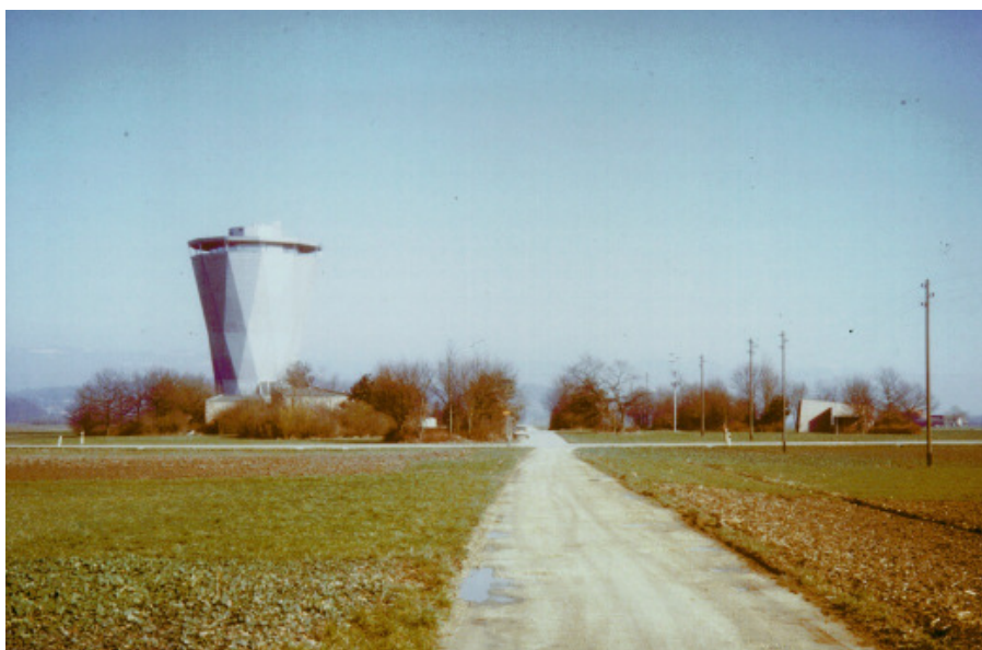
Wasserturm Gimmiz und Fassung Gimmiz 2 (Blick von Süden)
